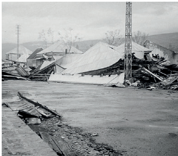
(Fig. 1 Dégâts causés par le cyclone de février 1948 au centre-ville de Saint-Paul © A. Blay)
