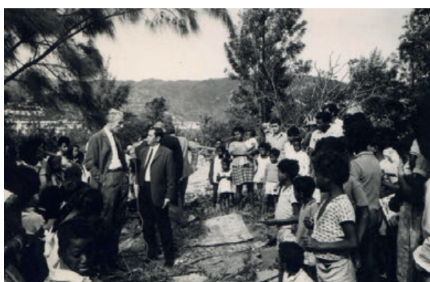
(Fig. 6 et 7 Destruction du bidonville Vauban 1969 © Albany coll. SIDR)
