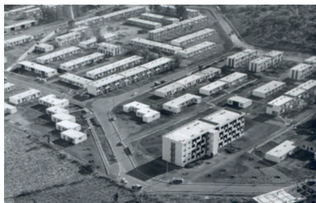
(Fig. 5 Le Chaudron en construction 1966 ©Albany coll. SIDR)
