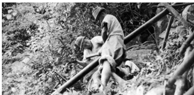
Adduction d'eau de l'hôpital de St-Denis, 1953-1957 Créateur non identifié, Archives départementales de La Réunion, 1028W37.62
